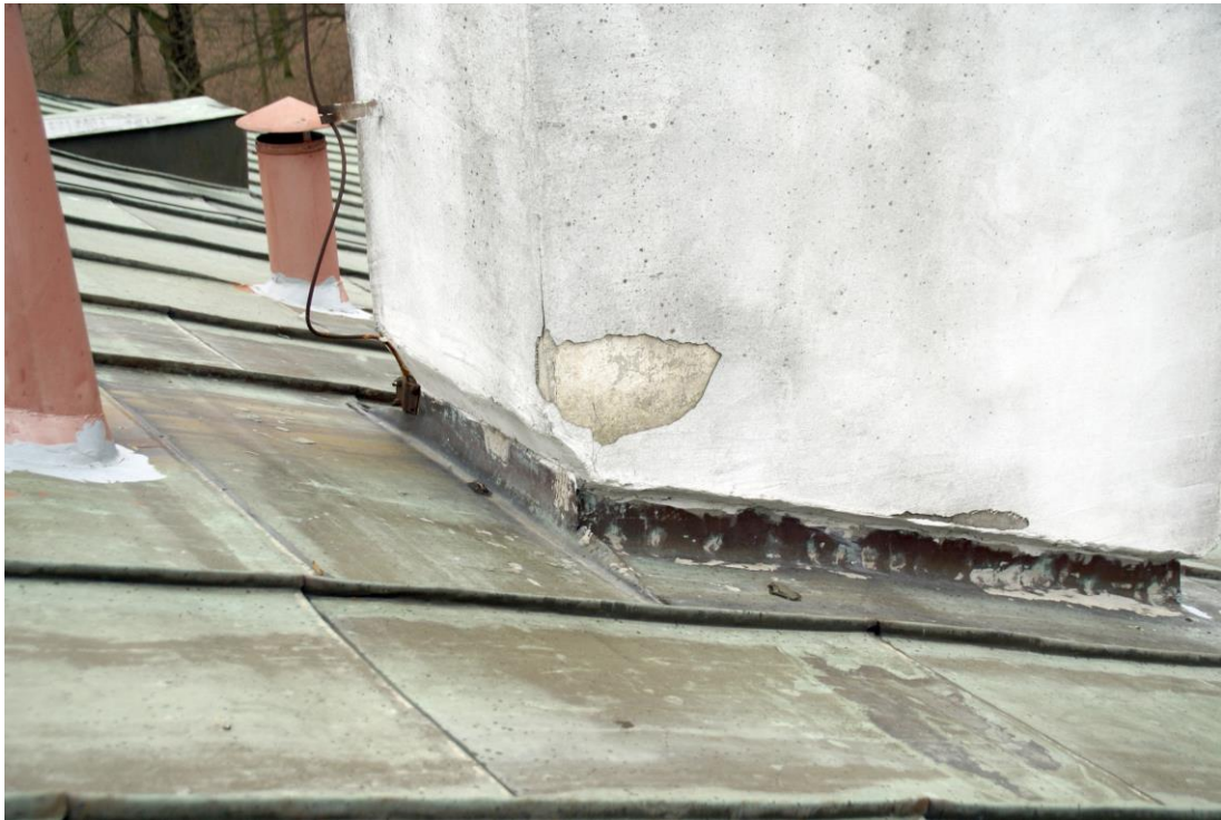
Fot. 13 Uszkodzenia powierzchni tynkowanych kominów.
