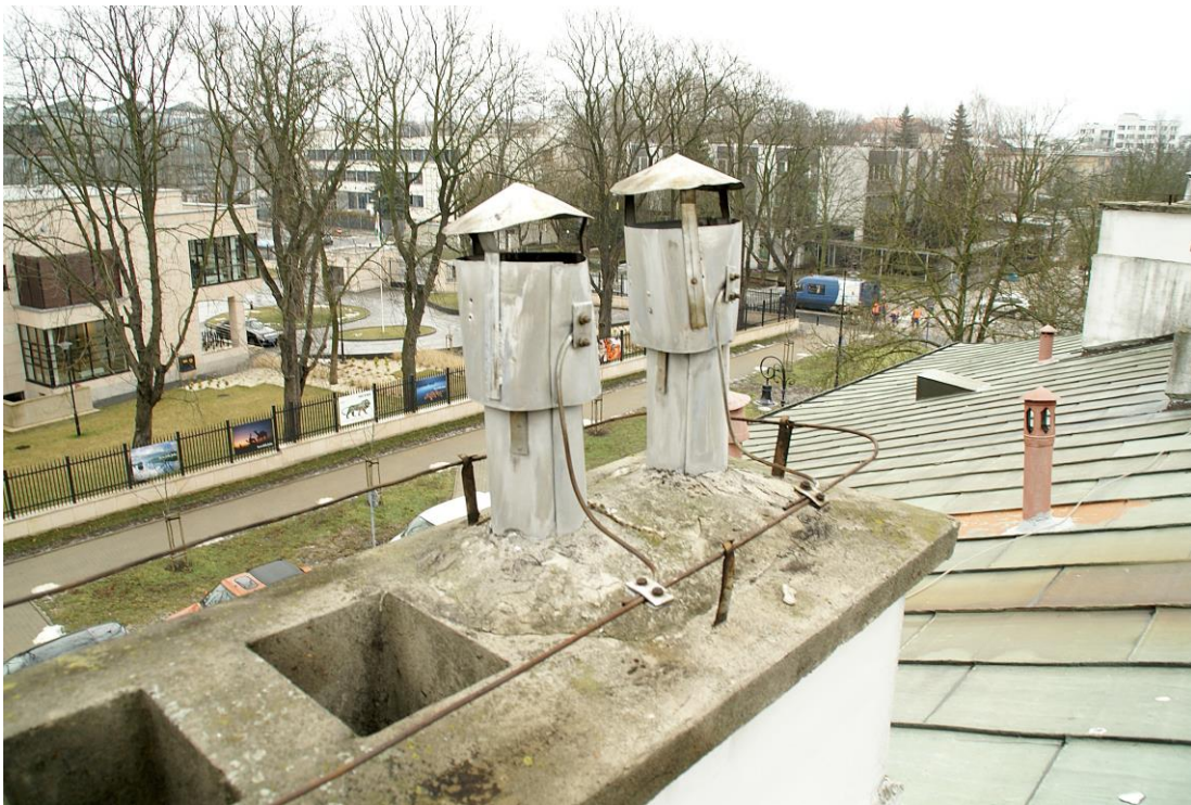
Fot. 10 Zniszczone wywiewki z blachy
