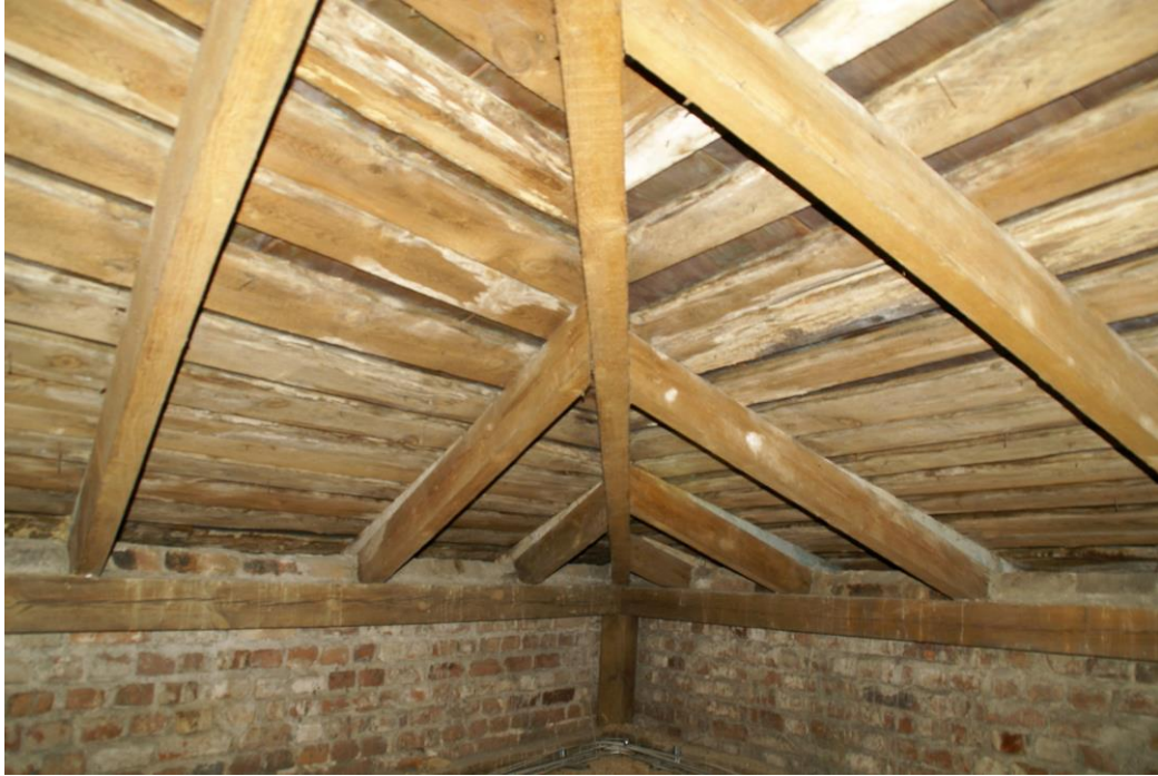
Fot. 17 Krokiew koszowa z widocznymi zaciekami na deskowaniu
