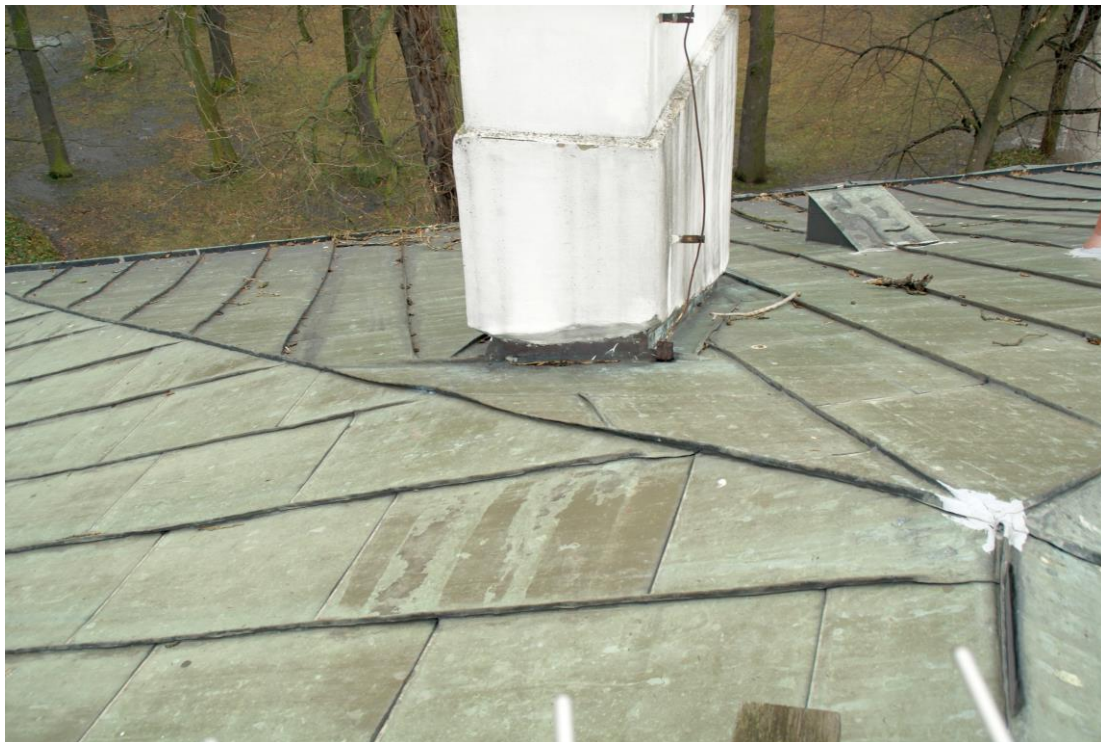
Fot. 8 Widoczne uszkodzenia mechaniczne rąbków blachy miedzianej
