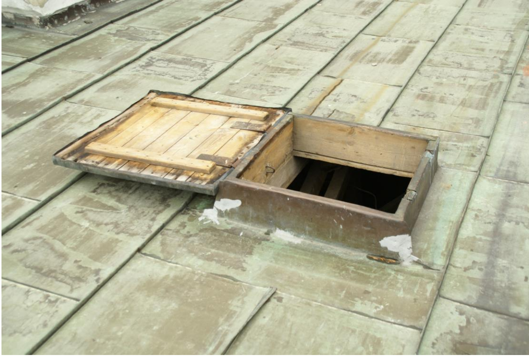
Fot. 11 Wyłaz dachowy
