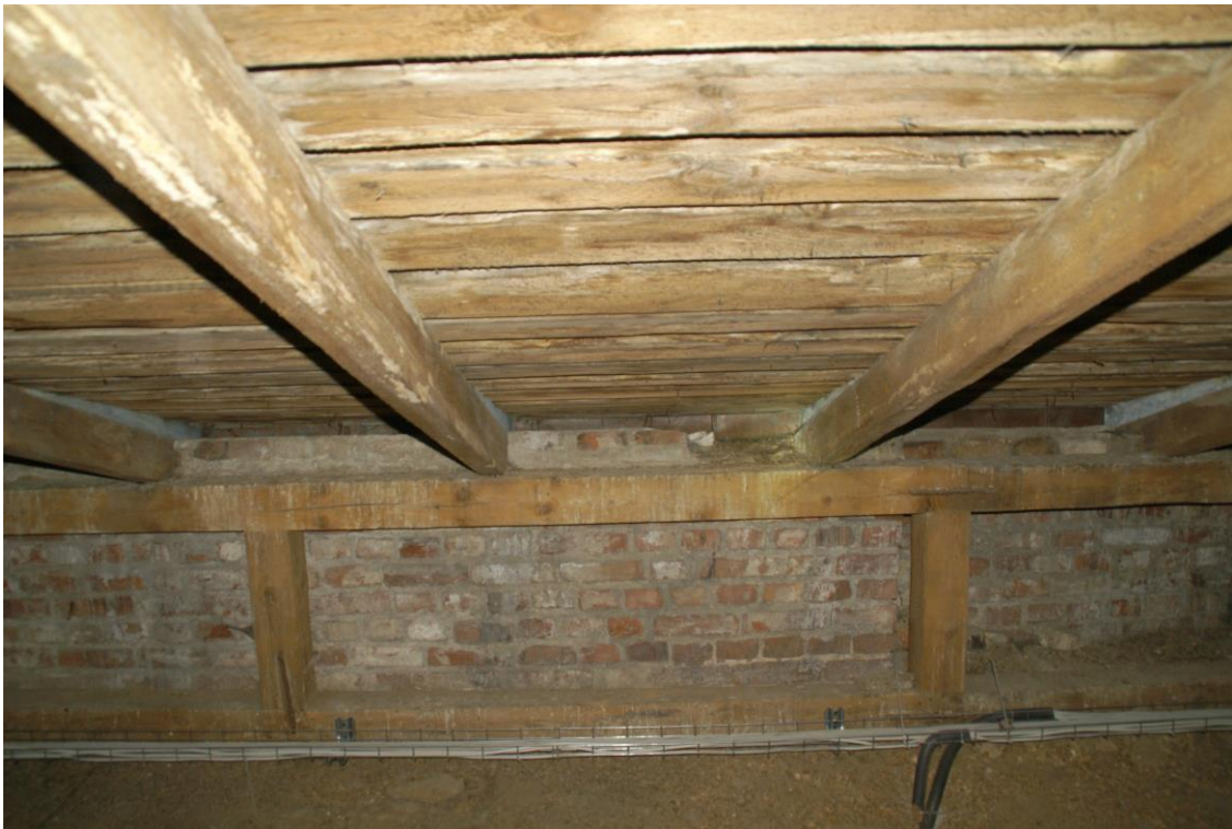
Fot. 18 Krokwie, murłata, podwalina – stan dobry
