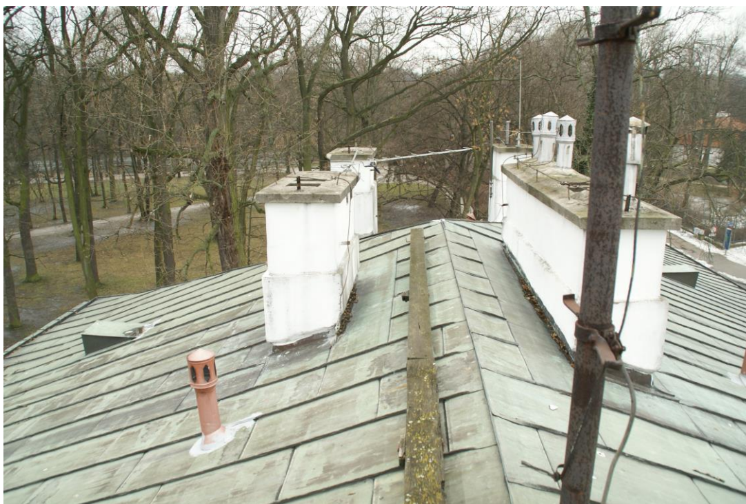
Fot. 6 Widok ogólny na dach w kierunku zachodnim. Widoczna zniszczona ława kominiarska.
