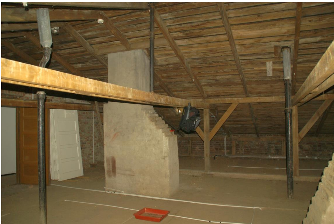
Fot. 14 Więźba dachowa – widok ogólny.
