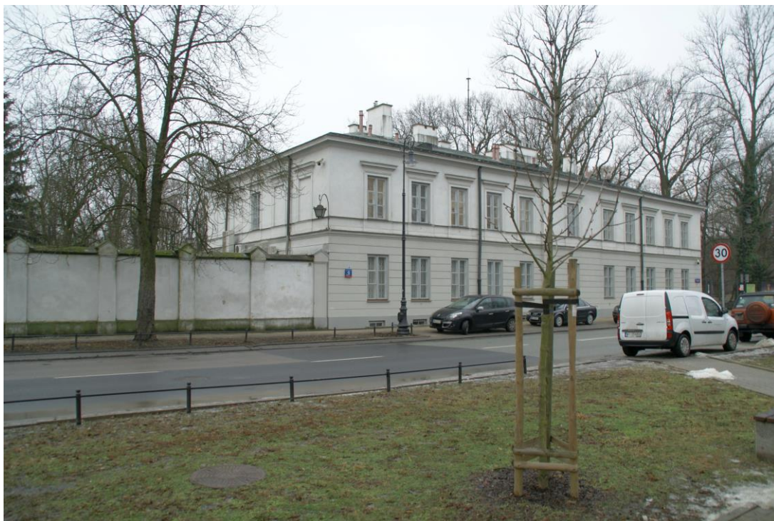
Fot. 1 Widok elewacji północnej i fragment elewacji wschodniej
