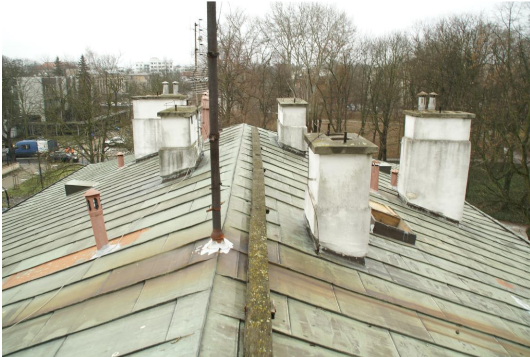
Fot. 7 Widok ogólny na dach w kierunku wschodnim. Widoczna zniszczona łąwa kominiarska i zniszczenia blachy miedzianej
