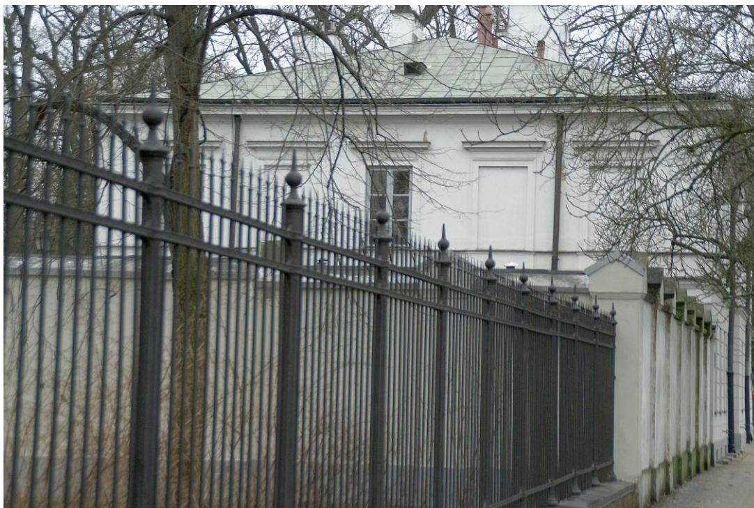
Fot. 5 Widok na elewację wschodnią
