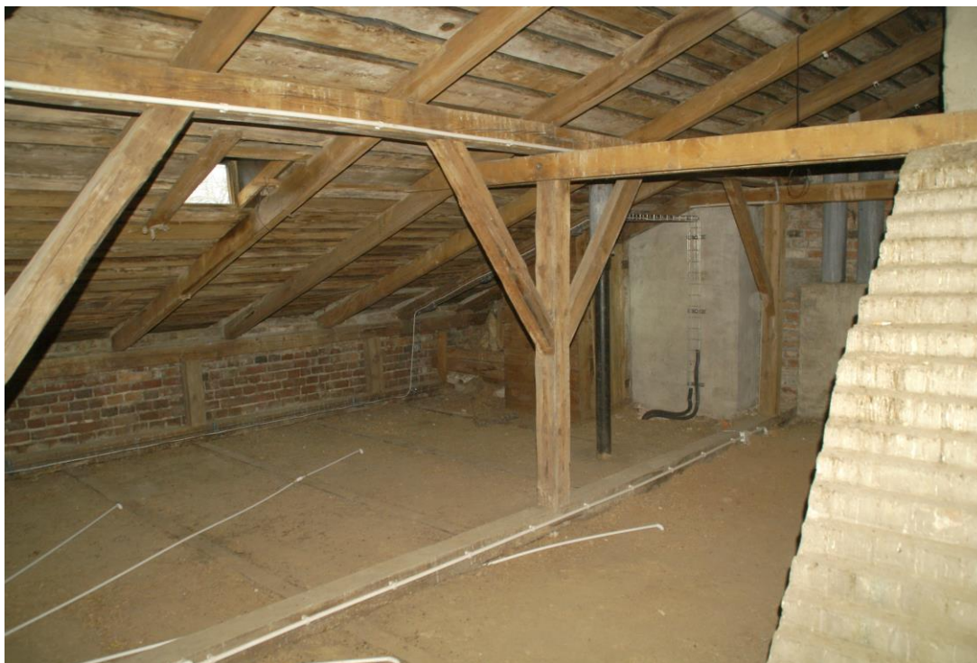
Fot. 15 Więźba dachowa – widok ogólny.
