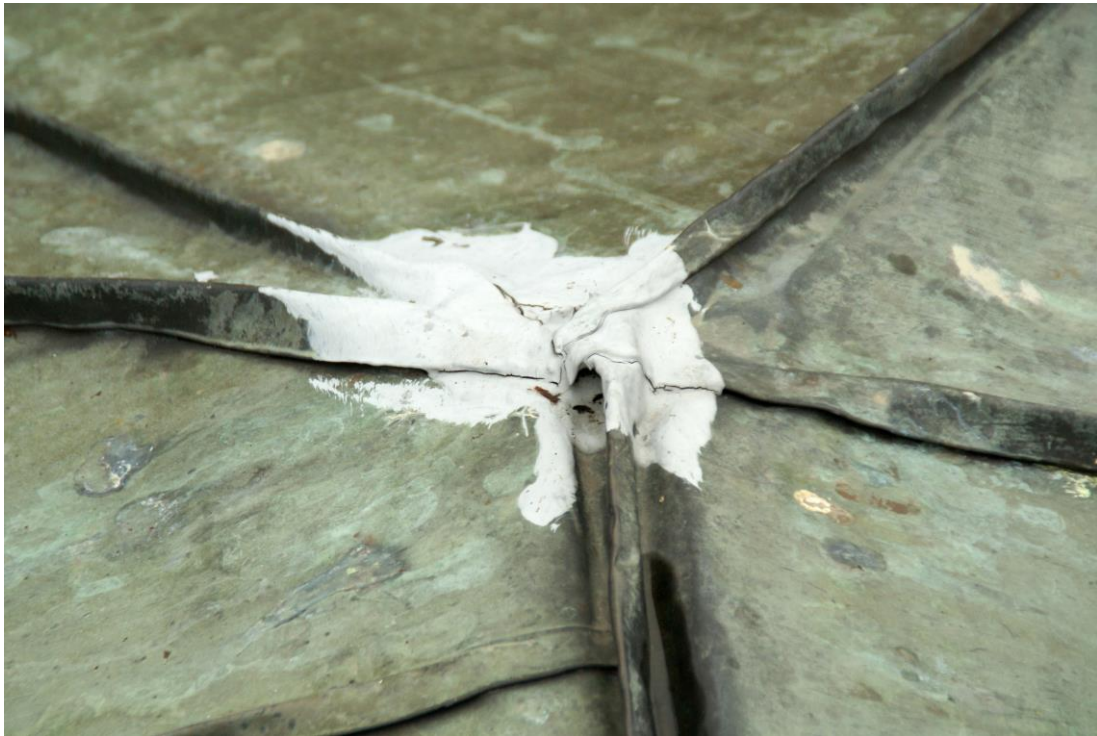
Fot. 9 Miejsce naprawy nieszczelności
