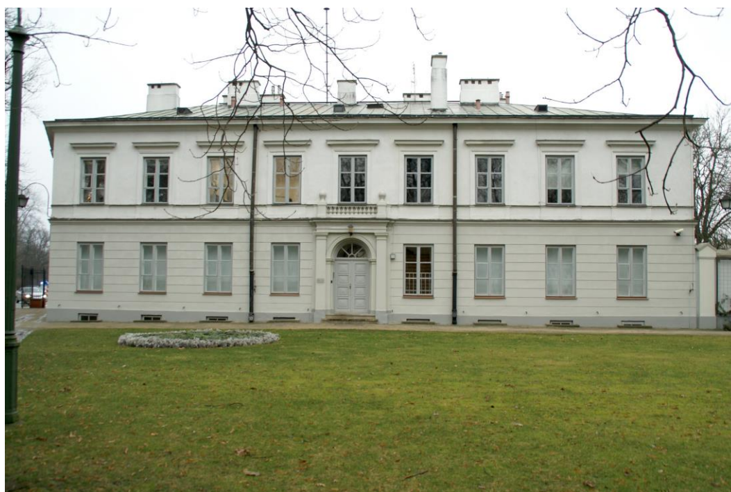
Fot. 4 Widok na elewację południową
