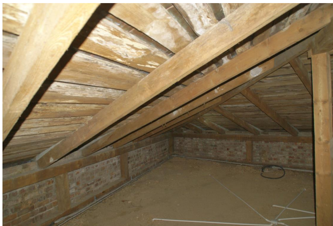
Fot. 16 Więźba dachowa z widocznymi śladami zacieków na deskowaniu
