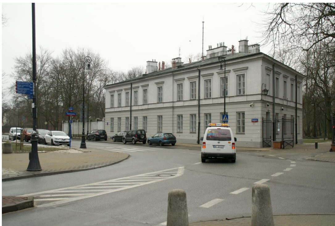
Fot. 2 Widok elewacji północnej
