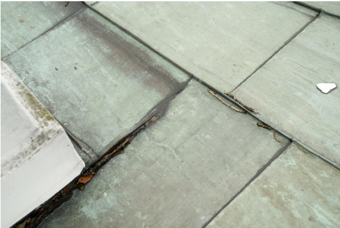
Fot. 12 Widoczne uszkodzenia blachy miedzianej.
