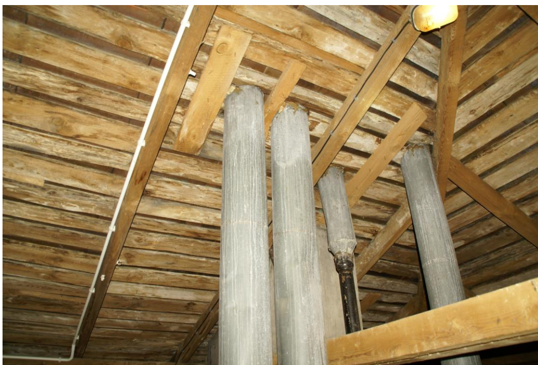
Fot. 20 Przejście wywiewek kanalizacyjnych przez deskowanie – widoczne przecieki
