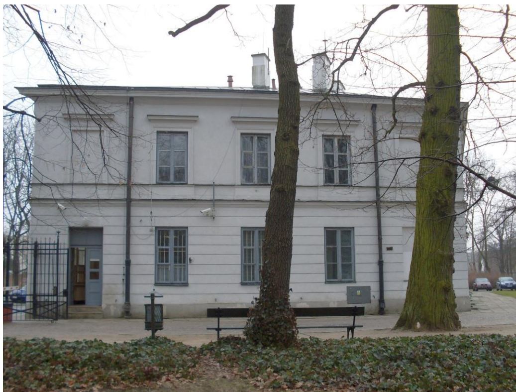
Fot. 3 Widok na elewację zachodnią
