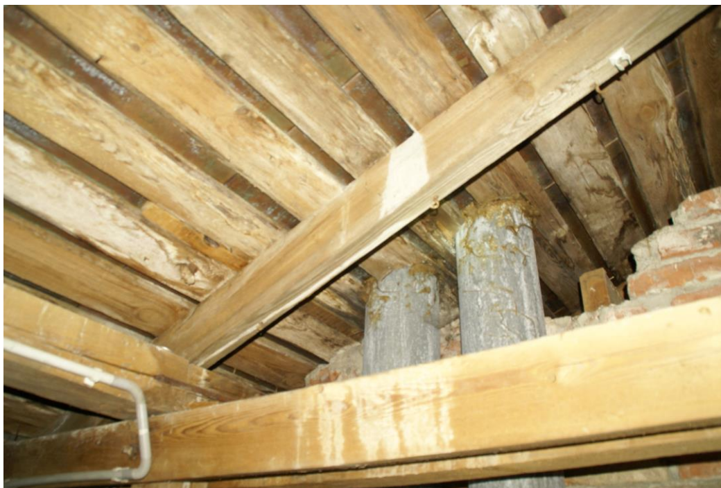
Fot. 19 Przejście wywiewek kanalizacyjnych przez deskowanie – widoczne przecieki
